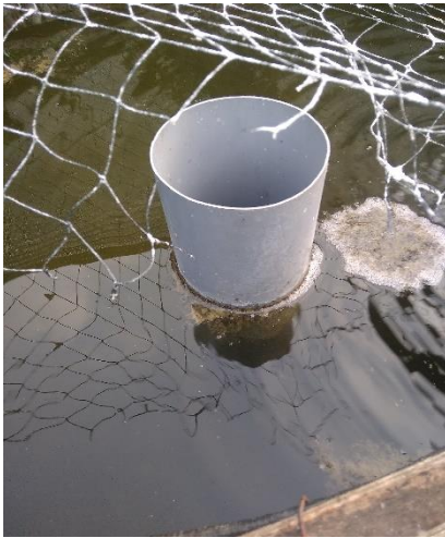
Saluran Pipa Pembuangan Air dari Kolam
