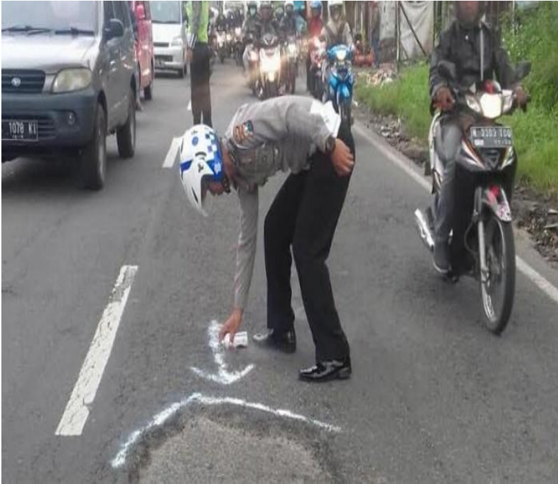
Gambar.2. Penandaan kerusakan jalan
