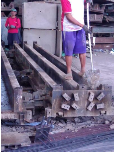
Lampiran 3. proses pembersihan cetakan tiang pancang
