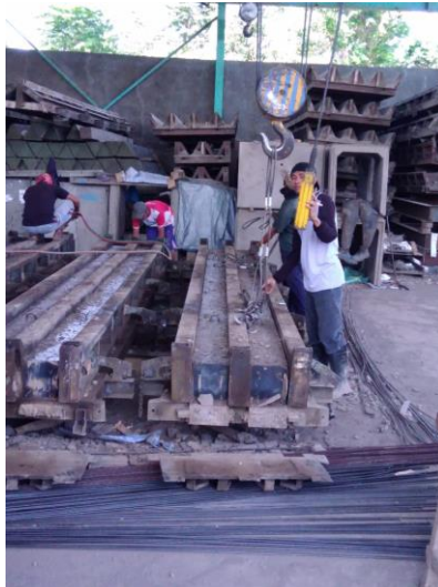
Lampiran 2. proses pengangkatan Tiang Pancang dari cetakan
