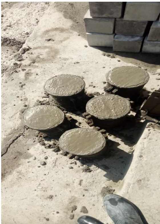
Beton Dimasukan ke Cetakan
