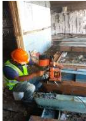
Gambar 4. 6. Pelubangan angkur Sumber : Studi lapangan
