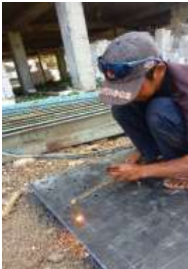
Gambar 4. 3. Pelubangan plat angkur Sumber : Studi lapangan
