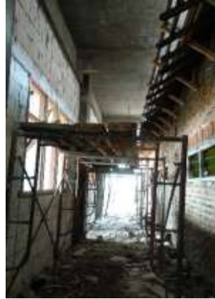
Gambar 4. 2. Scaffolding Sumber : Studi lapangan
