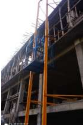
Gambar 4. 1. Lift crane Sumber : Studi lapangan
