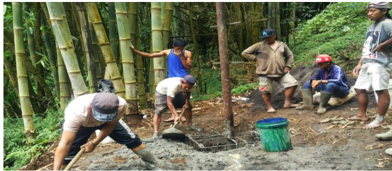
Foto kerjabakti pengecoran tempat wisata di Coban Waru
